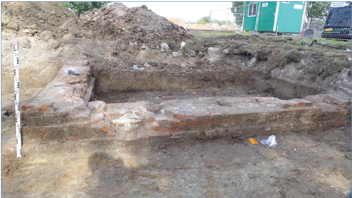
Figuur 9. Fundering (S1) gezien vanuit het zuiden.
