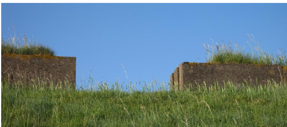
Afbeelding 9: Willemstad, muraltmuur op Oostdijk
