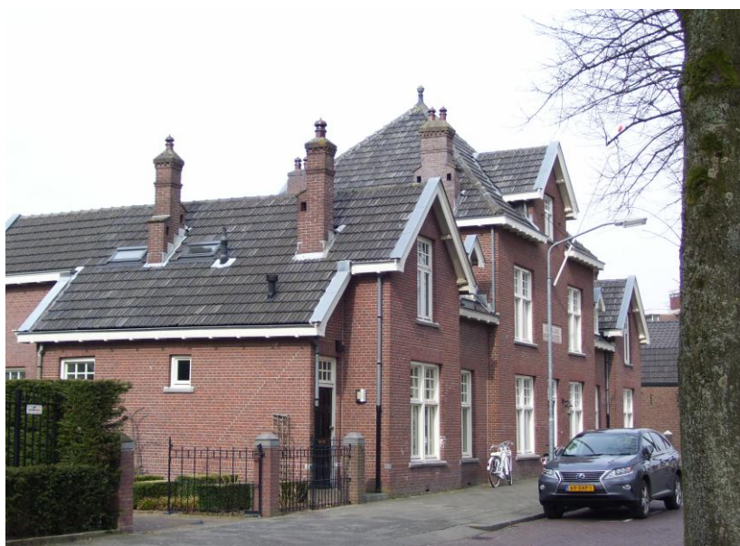
Afbeelding 69: Zevenbergen, woningen in voormalig politiebureau
