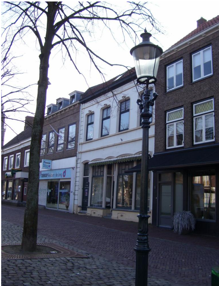
Afbeelding70: Zevenbergen, Markt 12: de enige nog overgebleven oorspronkelijke gevel aan de Markt
