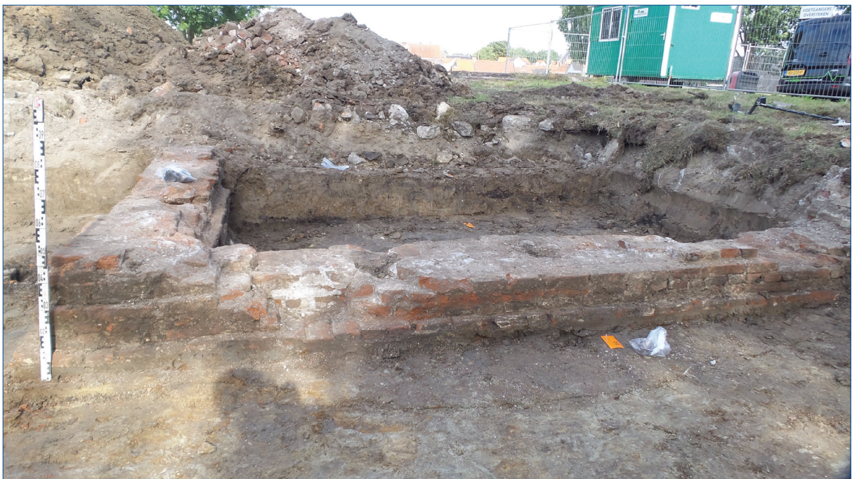
Figuur 9. Fundering (S1) gezien vanuit het zuiden.
