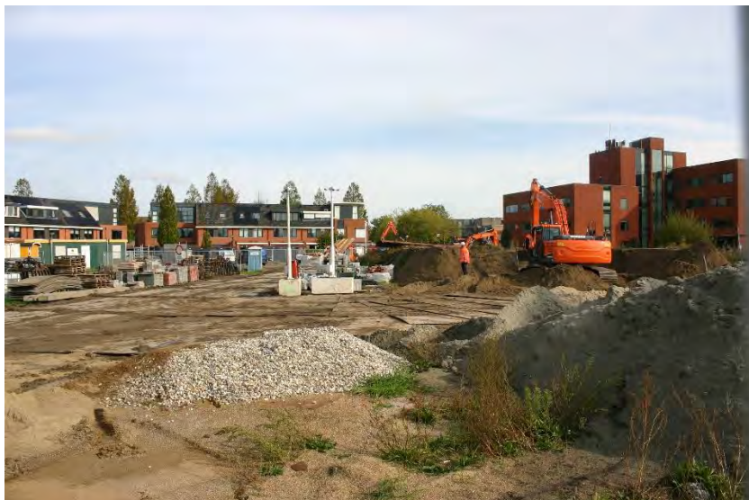
Figuur 4.1.5. Deelgebied 4; bouwplaats.
