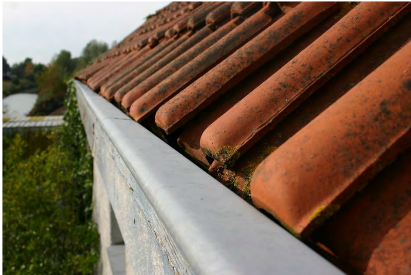
Figuur 4.4.1. Onder de onderste rij dakpannen is geen ruimte voor huismusnesten.
