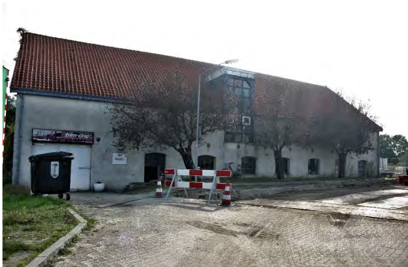
Figuur 4.1.4. Deelgebied 3; voormalige suikerfabriek aan Huizersdijk 3.
