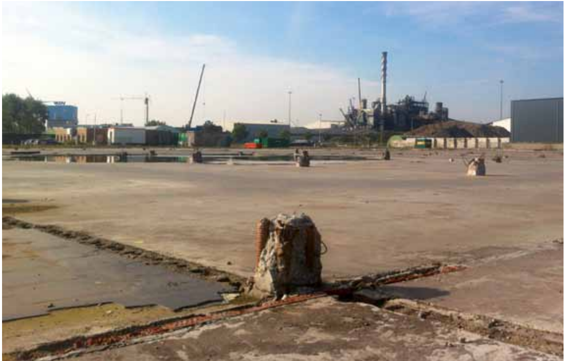
Er wordt hard gewerkt om de bodemverontreiniging op het oude terrein van Chemie-Pack ongedaan te maken.
