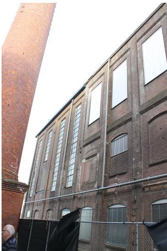
Rechterzijgevel richting straat
