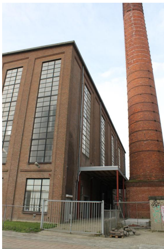
Rechterzijgevel met voorste schoorsteen
