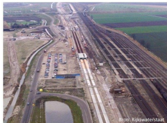
De HSL en het derde stationsgebouw in aanbouw, 2002
