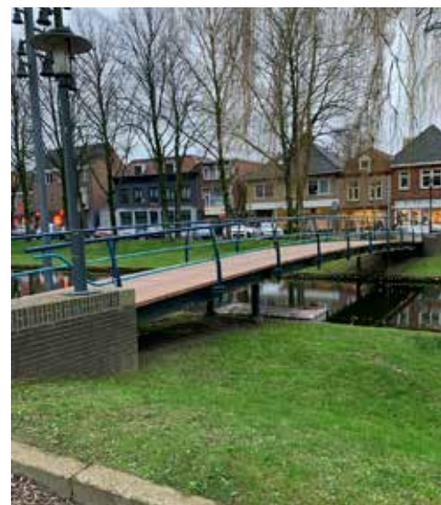
Eén van de opgeknapte bruggen in het centrum.
